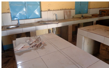
Laboratoire en construction au secondaire
