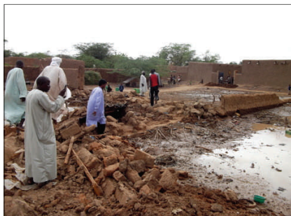
Maisons d'Abalak effondrées après la tempête et les inondations du 23 août
