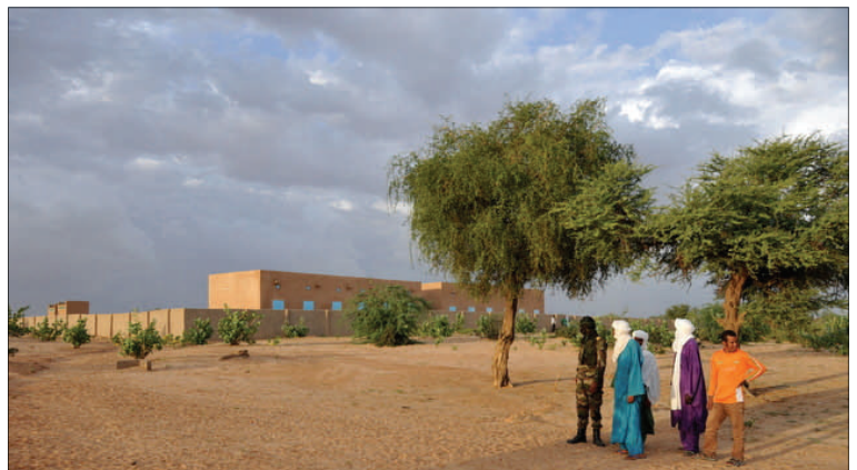
Le collège TANAT avec son nouveau mur d'enceinte
