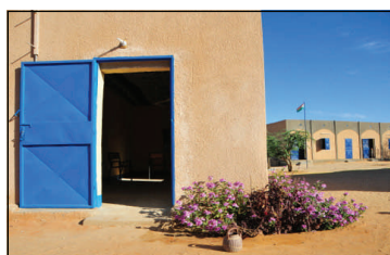
Le bâtiment administratif fleuri
