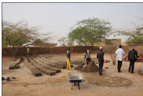
Le début des travaux de construction de l'école primaire en mars 2009
