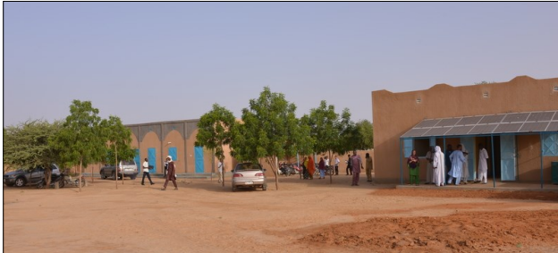
Le bâtiment administratif avec son auvent en panneaux solaires, la salle informatique et la bibliothèque de l'établissement secondaire.
